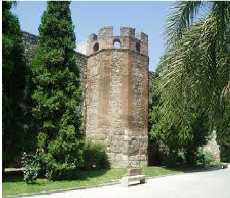
Torre exagonal. Murallas de Talavera de la Reina.
