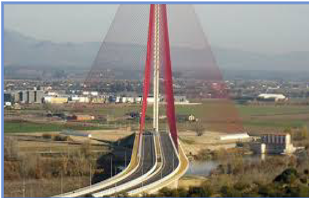
Puente de Castilla La Mancha. Talavera de la Reina
