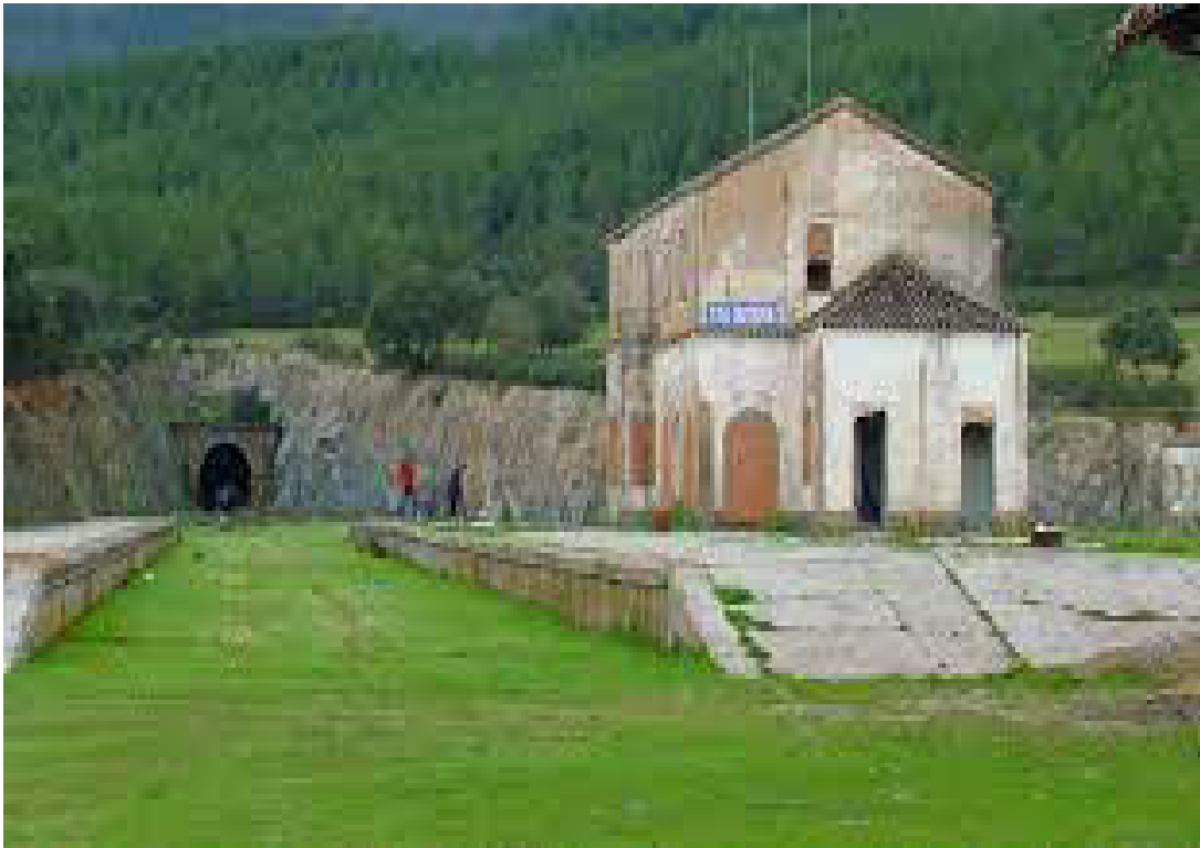
VIA VERDE DE LA JARA, ESTACION DE SANTA QUITERIA - MINAS DE SANTA QUITERIA.
