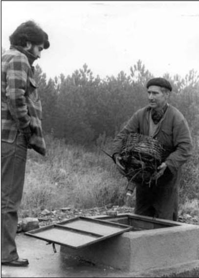
Figura 4.6. Colocando una garrafa invertida para cloración.
